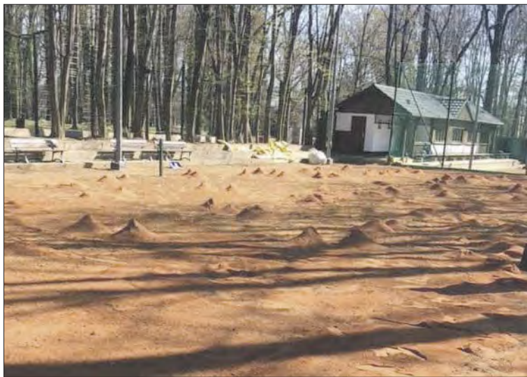
Na kort została wysypana mączka ceglana
