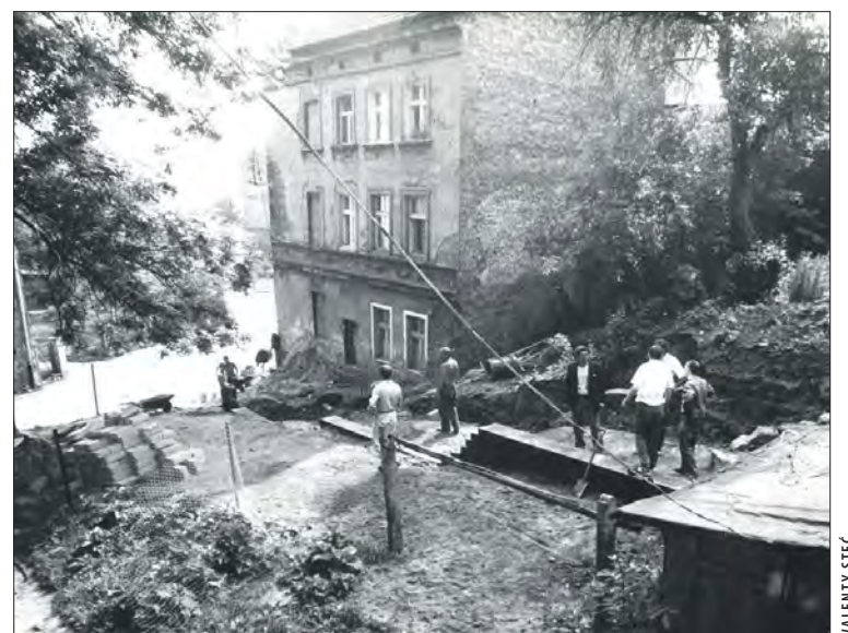
Fotografia z remontu schodów. Czyżby w 1989 roku?
