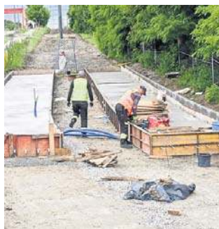
Na razie prace trwają na prostym odcinku
