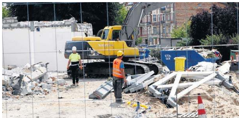
W ostatnich dniach wyburzono ostatnie budynki po Circle K
