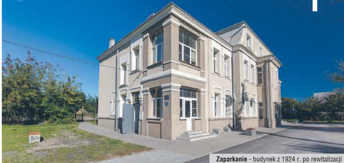
Zaparkanie - budynek z 1924 r. po rewitalizacji
