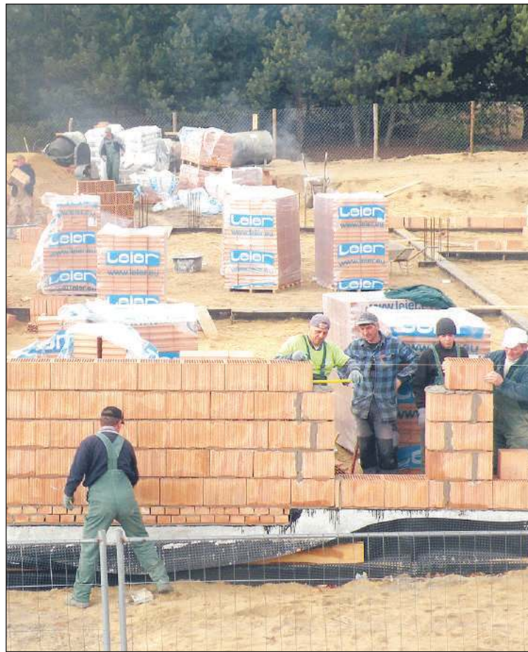
Budowę żłobka w Brzeźnicy zajmuje się tarnowska firma Anko.
