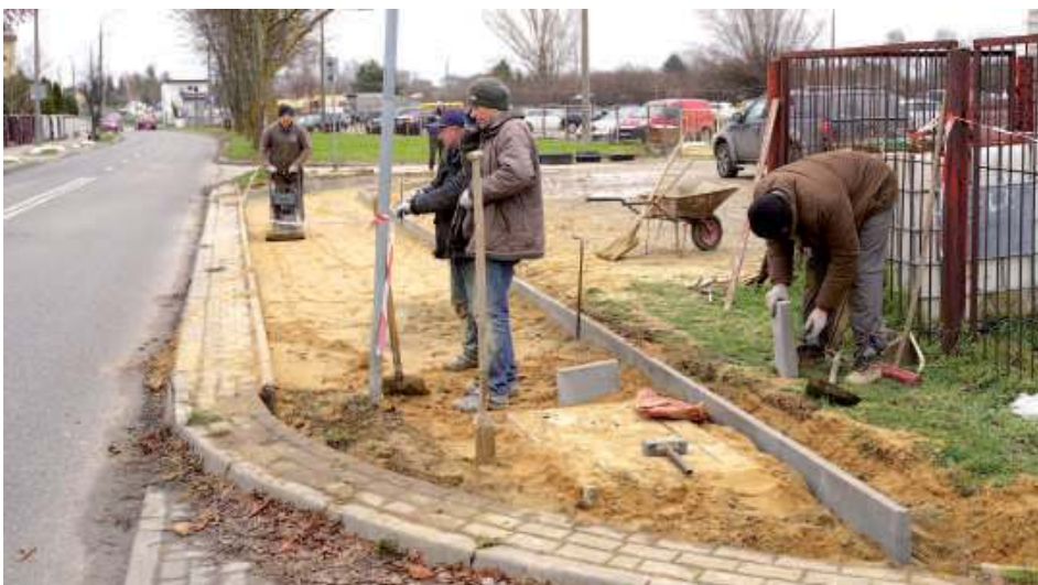
Prace związane z rozbudową parkingu przy ul. Wojska Polskiego. Zadanie wygrało w głosowaniu mieszkańców osiedla Niepodległości w ramach budżetu osiedlowego
