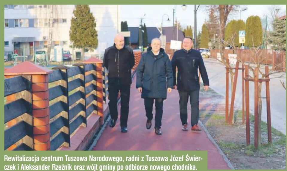
Wójt gminy i sołtys Malinia w trakcie budowy długo oczekiwanego i bardzo potrzebnego chodnika w Maliniu.
