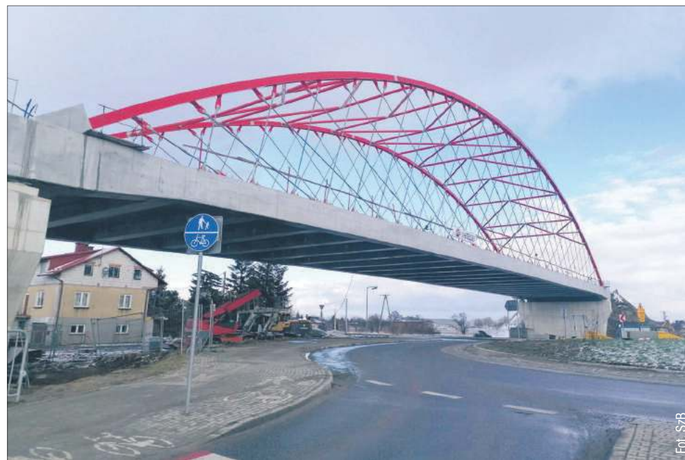
Kierowcy mogą już oglądać ogromną konstrukcję wiaduktu.
