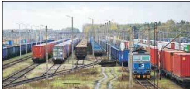
Rozpoczęcie prac budowlanych w Parku Logistycznym Małaszewicze zaplanowano na 2023 r.
