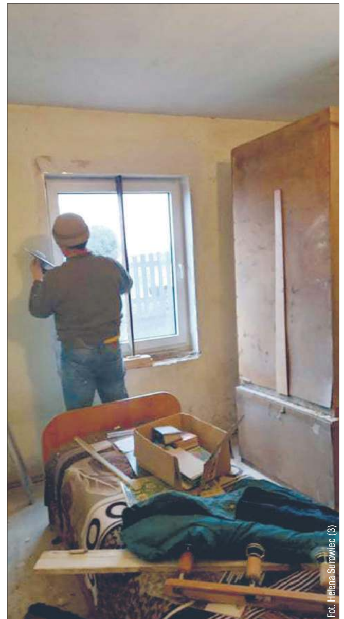
Okna już wymienione, ale czeka jeszcze sporo pracy.
