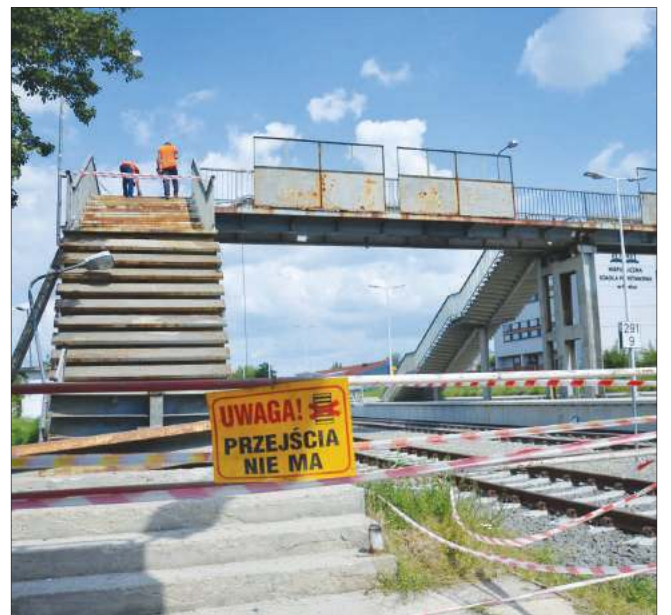
W ubiegłym roku kładka nad torami przeszła do historii.
