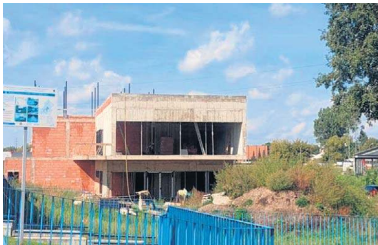
Budynek powstający po starym młynie nad zalewem na Borkach.
