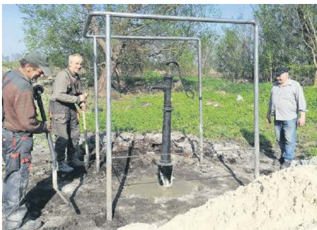
W ubiegłym tygodniu zamontowano pompę do ręcznego czerpania wody ze studni głębinowej. Fot. wd
