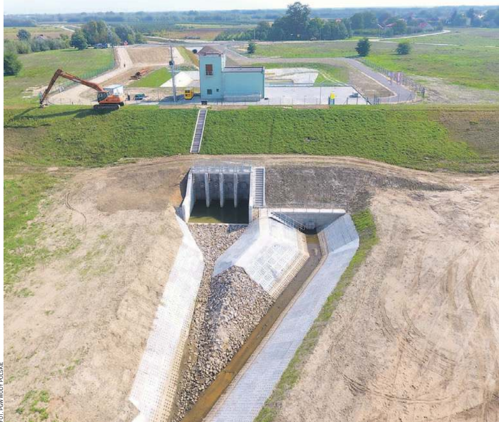
Budowa nowej pompowni „Koćmierzów”
