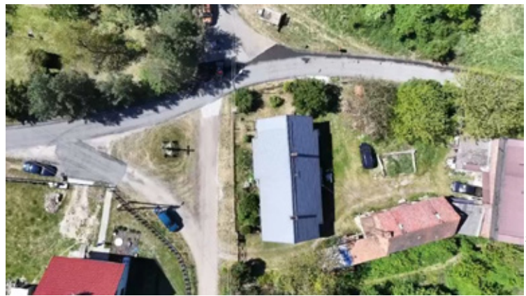
Lubiąż, remont ul. Św. Jadwigi.
