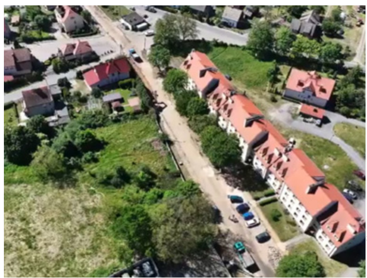
Remontowana ul. Mickiewicza.
