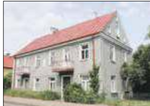
W połowie sierpnia pracownicy WKZ w Lublinie przeprowadzili postępowanie administracyjne, w ramach którego budynek klasztoru został opisany i udokumentowany zdjęciowo
