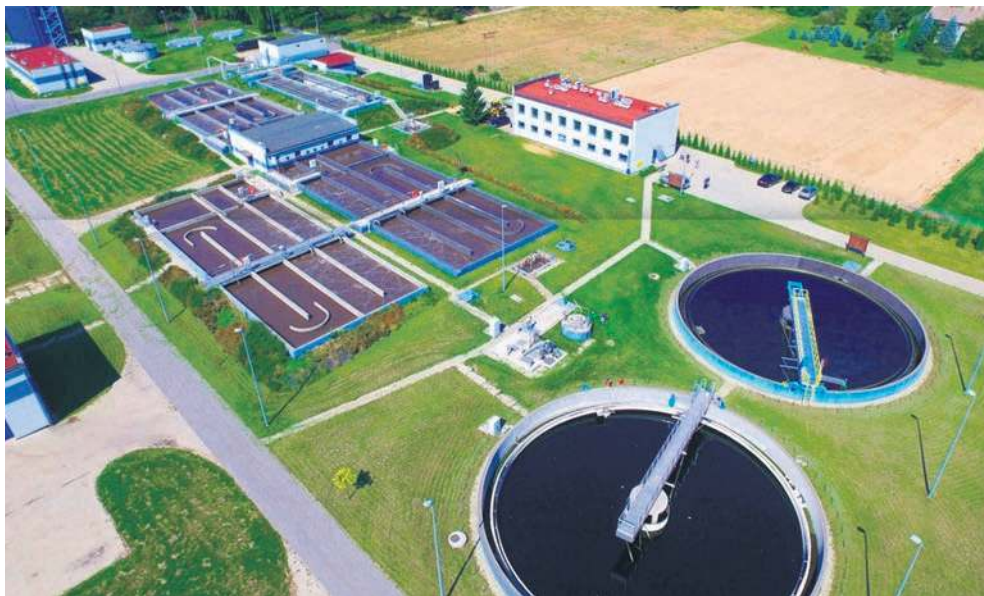
Oczyszczalnia ścieków w Krzeszowicach. Zdjęcie ze strony internetowej spółki Wodociągi i Kanalizacja w Krzeszowicach
