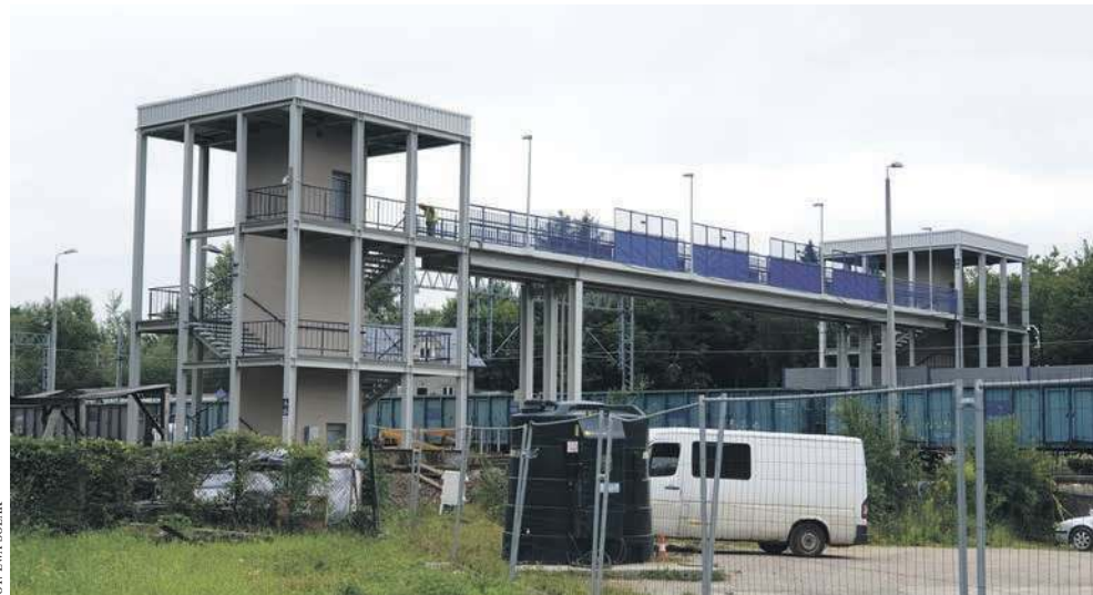
Nowa kładka nad torami w Gwoźdźcu już stoi
