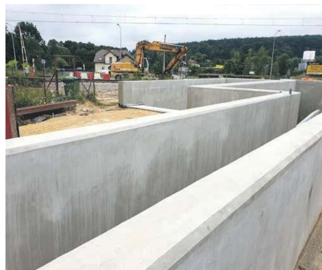
Budowa przejścia podziemnego na ul. Sienkiewicza trwa
