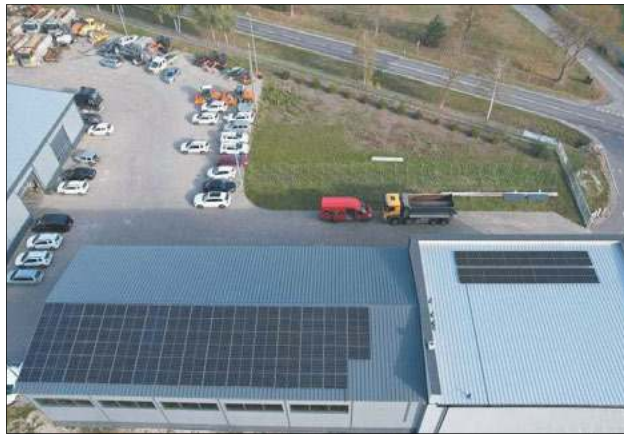
Przedsiębiorstwo wykonuje montaż paneli na potrzeby klientów indywidualnych, rolników i firm
