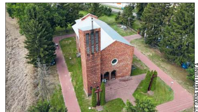
Jednym z zakończonych już projektów, dofinansowanych z Rządowego Programu Odbudowy Zabytków jest nowe pokrycie dachowe i system odwodnienia w kościele w Turowie
