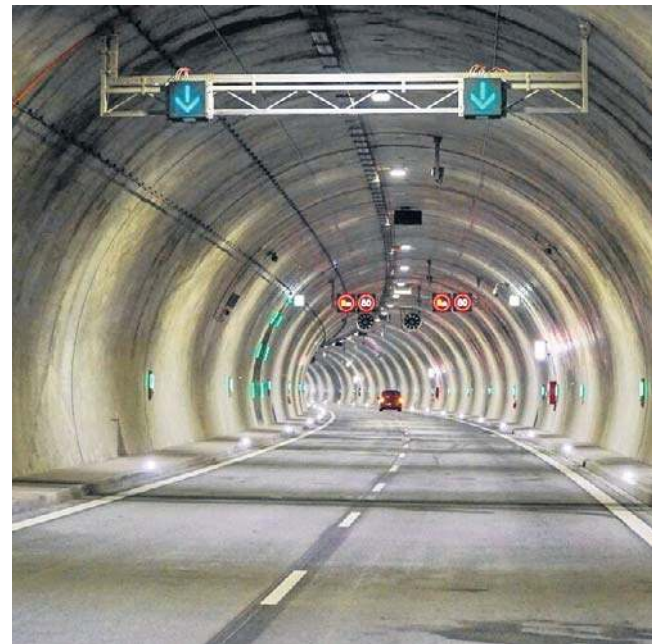
Na obwodnicę Węgierskiej Górki składają się m.in. dwa tunele. Są monitorowane, z nowoczesnymi systemami
