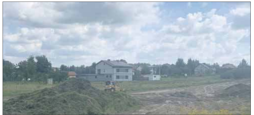
Wiadukt ma mieć około 120 metrów długości
