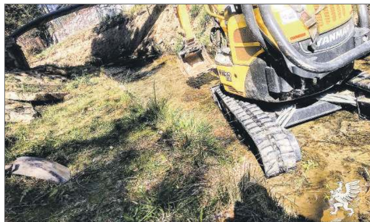
By wyczyścić niektóre odcinki potrzebna była koparka.
