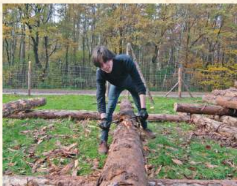
■ Okorowywanie drewnianych bali wymaga wprawy, siły i wytrzymałości. Pozbawione kory drzewo zostało zaimpregnowane, zaostrome, a następnie użyte do budowy palisady.
