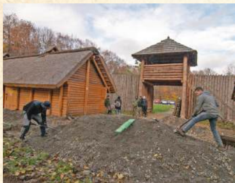
■ Wojciech Żółtecki rozplantowuje żwir, który posłużył do utwardzenia terenu grodziska
