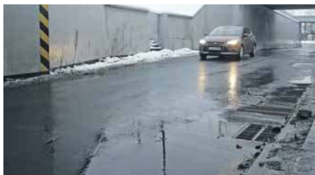
Bez przebudowy kanalizacji deszczowej problem zalanej drogi pod wiaduktem na ul. Częstochowskiej raczej nie zniknie. Na razie jednak żadne prace się nie zaczęły
