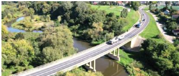
Obecny most powstał w 1966 r. i jego stan z roku na rok się pogarsza, co doprowadziłoby do konieczności ograniczenia tonażu poruszających się po przeprawie pojazdów
