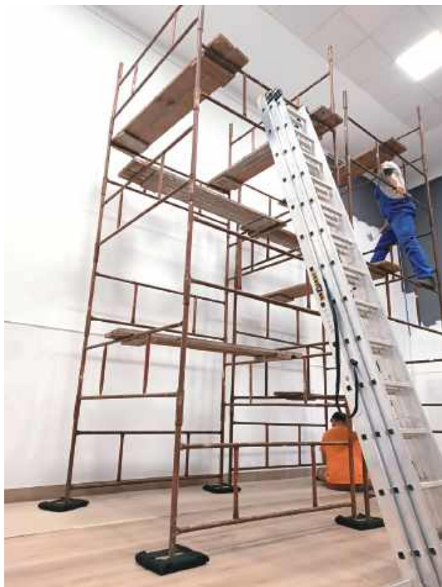
W sali widowiskowej trwa gruntowny remont, na który składają się malowanie ścian, odświeżanie przestrzeni, zmiana podłogi, wymiana kotar i zainstalowanie nowego oświetlenia
