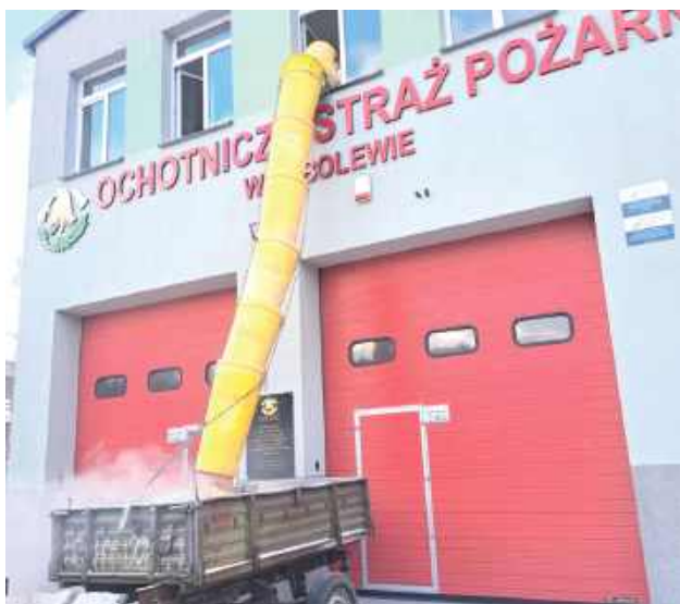
Prace remontowe w większości będą wykonywane własnymi siłami przy znacznym udziale druhów z OSP Sobolew
