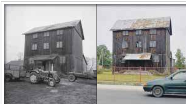
Kilkadziesiąt lat temu młyn w Łomazach tętnił życiem. Przyjeżdżali tu rolnicy z całej okolicy, aby przemielić zboże. Dziś budynek nadszarpięty zębem czasu przypomina mieszkańcom o swej dawnej świetności
