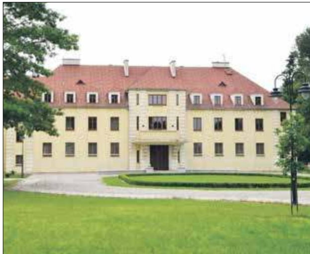
Rewitalizacja pałacu Potockich kosztować ma łącznie prawie 4 mln złotych. Dzięki niej budynek odzyska swój dawny blask
