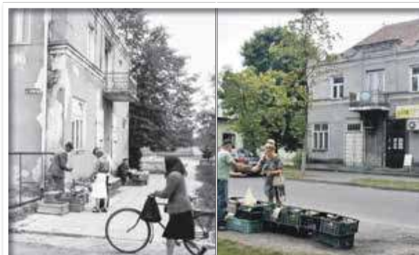
Pod budynkiem dawnego Banku Spółdzielczego, a następnie komisariatu policji niegdyś kwitł handel. Obecnie mieści się tam biuro GS Łomazy, zakład krawiecki oraz sklep mięsny. Obok nie brakuje prywatnych sprzedawców
