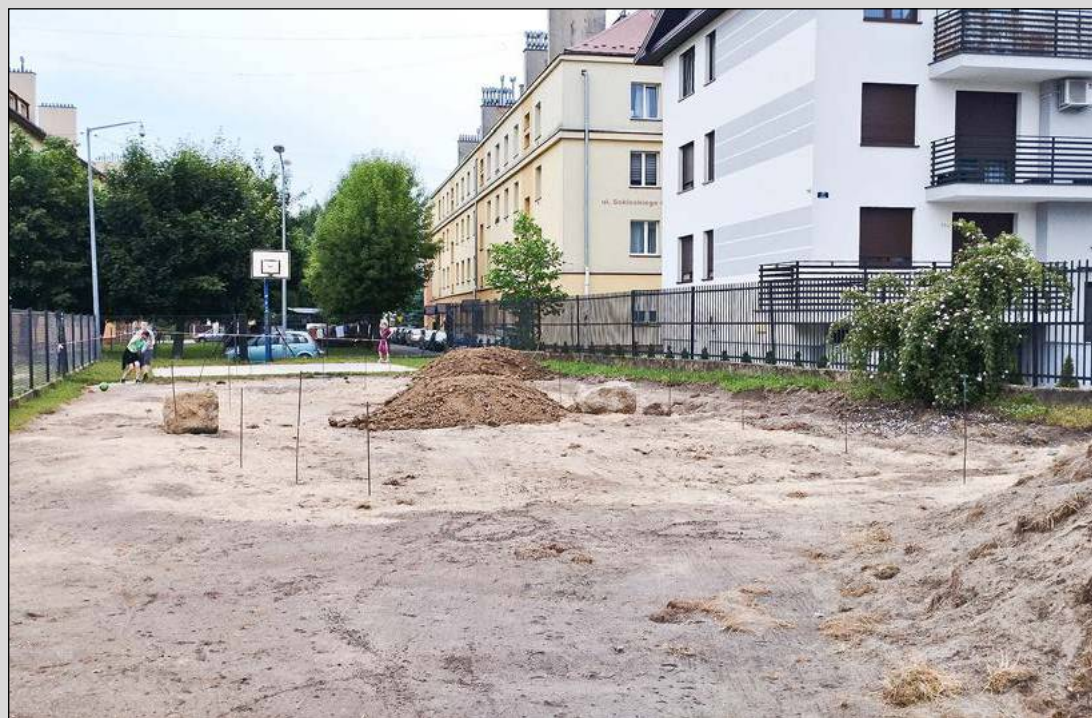
Trzy parki kieszonkowe powstaną niebawem w Dębicy, a place budów zostały już przekazane wykonawcy. Jeden powstanie przy ul. Ogrodowej, drugi na Batorego, obok Urzędu Gminy Dębica, a trzeci na os. Matejki. Na działkach ustawione zostaną ławki, powstaną alejki, a także zasadzone zostaną różne gatunki roślin. Wszystko po to, by można było spokojnie usiąść i odpocząć. Na zdjęciu powstający park przy Ogrodowej, o który wnioskował radny Piotr Michoń.
