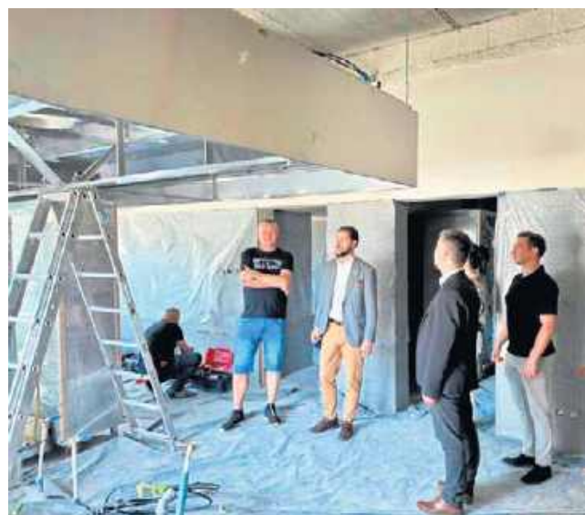
W Skokach powstaje samorządowy żłobek „Skaczące Brzdące”.
