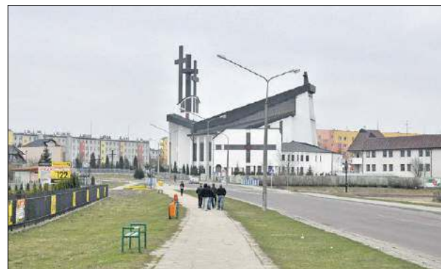
Jak informuje magistrat, przeprowadzona zostanie kompleksowa modernizacja ul. Wyszyńskiego z infrastrukturą podziemną, która wymaga modernizacji, wykonane zostaną ciągi piesze, parkingi, ścieżka rowerowa
