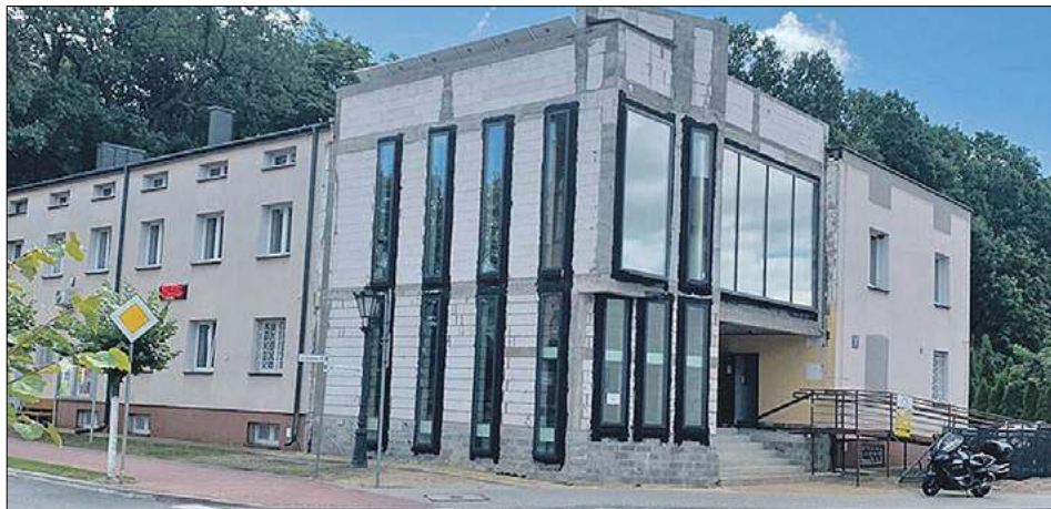
Trwają prace wykończeniowe wnętrza nowej części urzędu gminy, które zostaną zakończone do 31 marca tego roku
