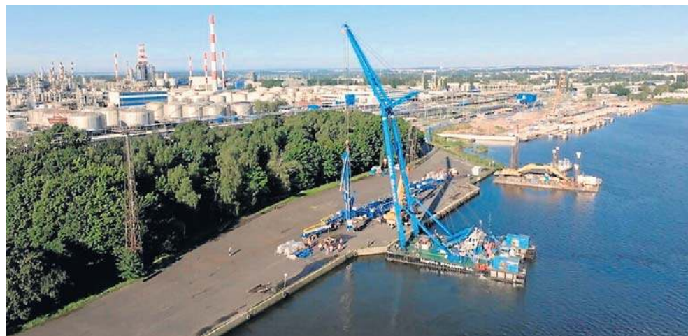
Do operacji montażu nalewaków, o wadze 18 ton każdy, wykorzystano największy dźwиг pływający, jaki jest do dyspozycji w Gdańsku
