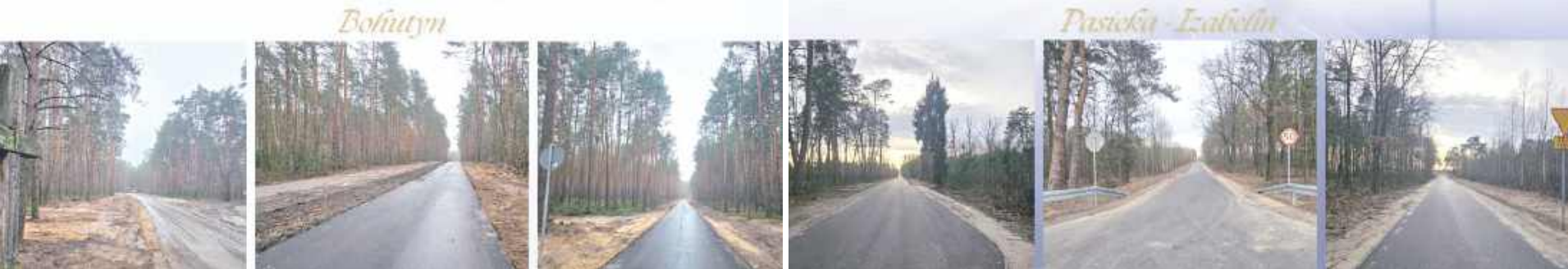
W gminie Sosnowica powstały dwie drogi
