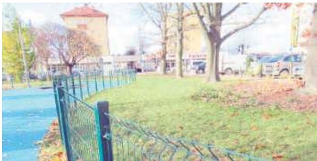
Wandale zniszczyli m.in. huśtawkę, klamki w furtkach oraz przesła ogrodzenia placu zabaw.
