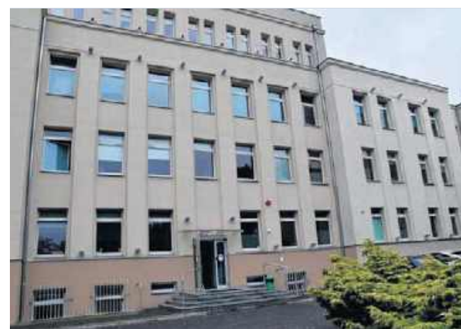
Blok operacyjny na oddziale ginekologicznym w kaliskim szpitalu wyłączony z użytkowania.
