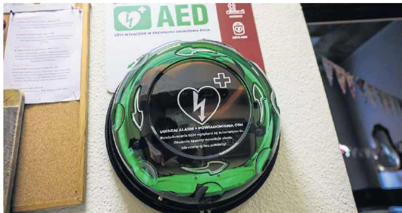
Aparat AED dostępny przy ul. Wielkiej w Poznaniu, gotowy do użycia w sytuacji zagrożenia życia, efekt projektu w ramach PBO
