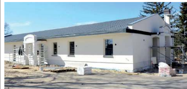
Na terenie starego szpitala w Jaszczowie powstaje zupełnie nowy budynek
