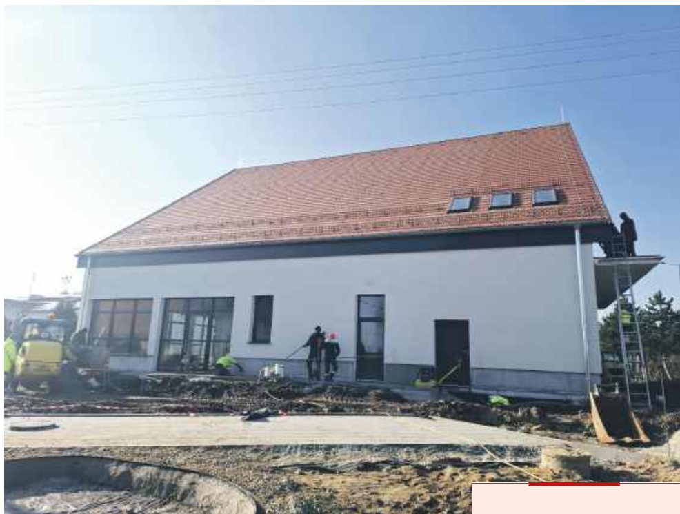
Trwają prace przy budowie przedszkola w Krynicznie
