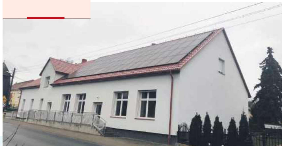
Świetlica w Piotrkowiczkach po pracach termomodernizacyjnych
