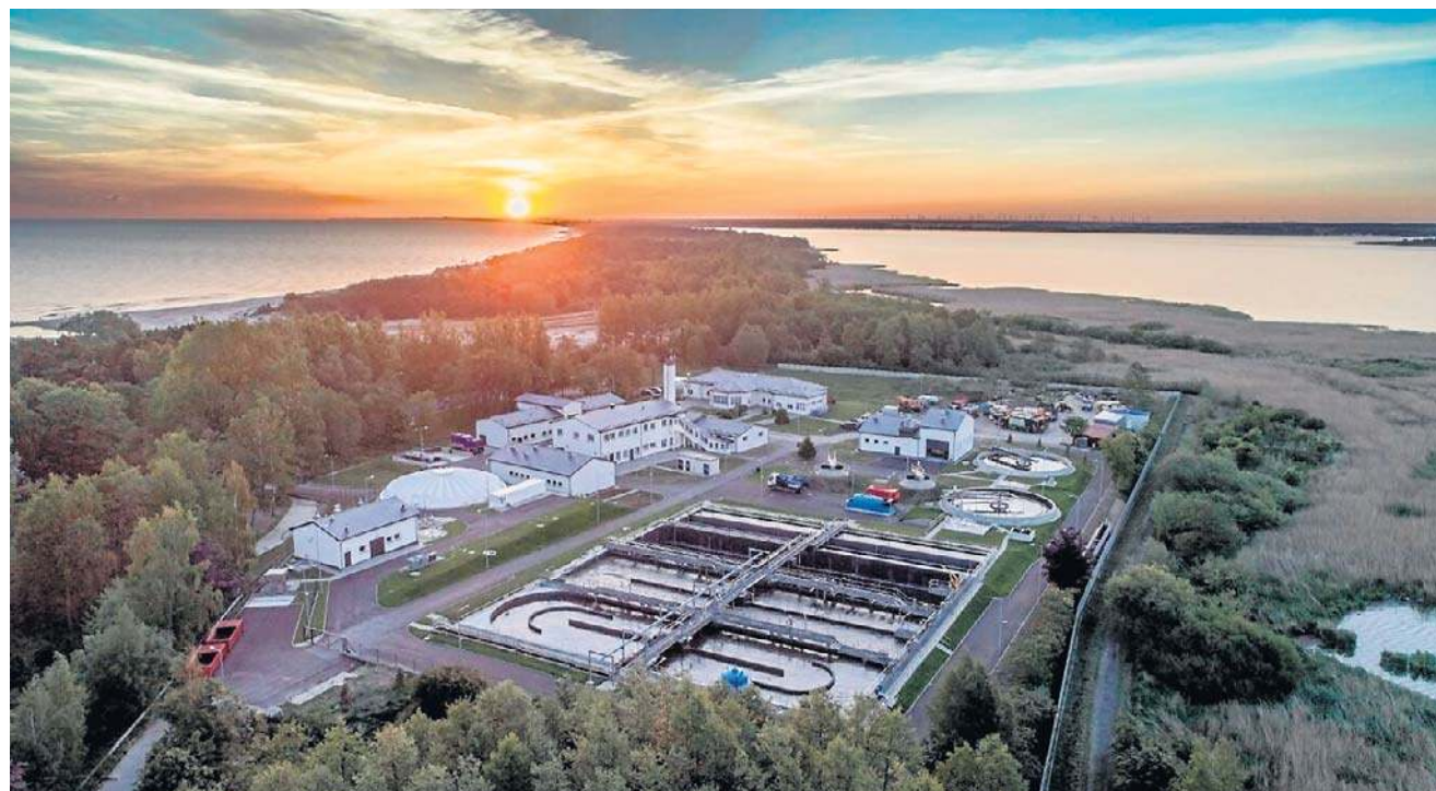
Dzięki inwestycji mieszkańcy Mielna będą mieli pewność, że korzystają z nowoczesnej i bezpiecznej infrastruktury
