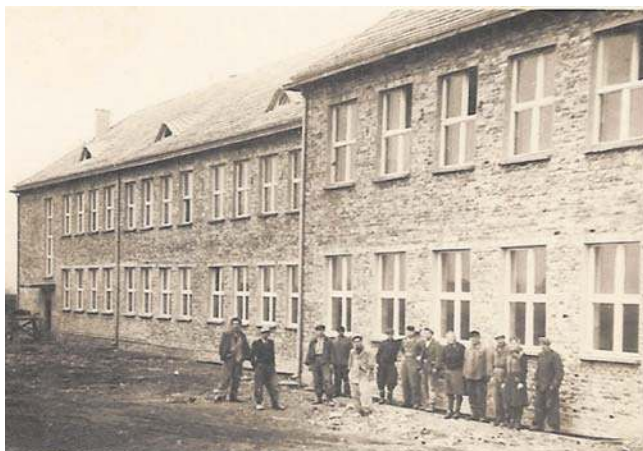
SP Rymań i jej budowniczowie 1952 r.
