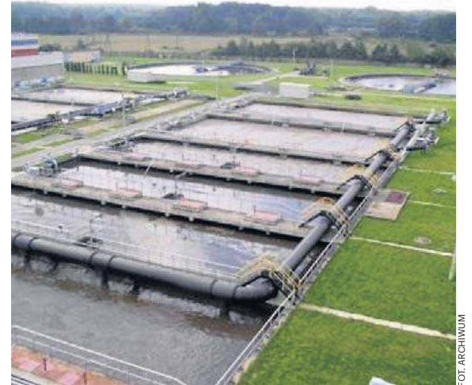
Oczyszczalnia ścieków w Jamnie
