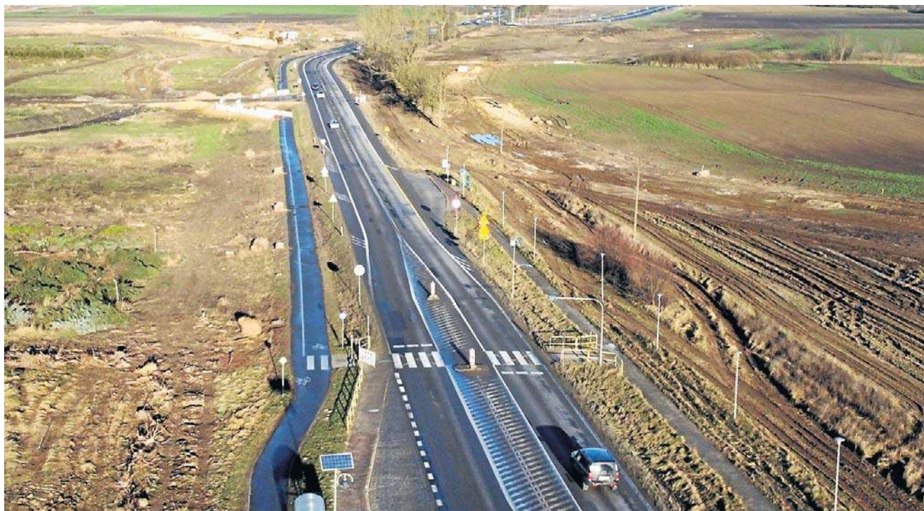
Budowy obwodnicy Warzymic i Przecławia, która będzie jednocześnie fragmentem ZOS-i i umożliwi dojazd do A6.
