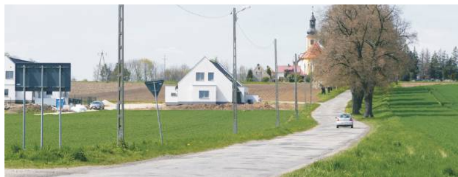
Starostwo Powiatowe w Strzelinie otrzymało dofinansowanie na remont ul. Siemysławickiej w Przewornie
