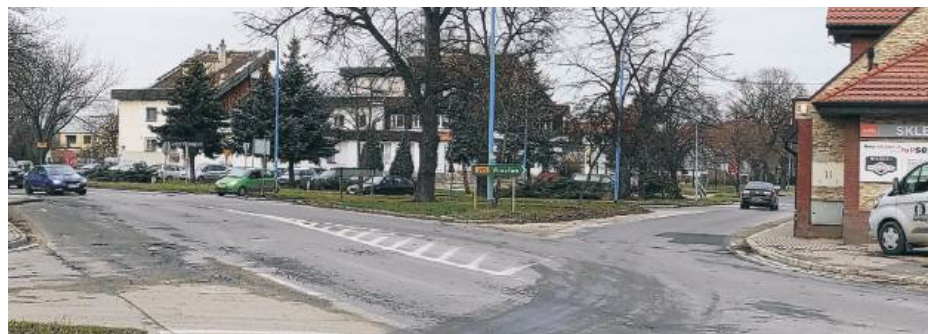
W ramach remontu kolejnego odcinka ul. Wolności w Strzelinie planowana jest przebudowa skrzyżowania u zbiegu ulic Wolności, Oławskiej i Wrocławskiej
