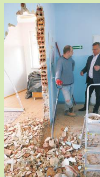
W Ośrodku Zdrowia w Przewornie trwa remont toalet
