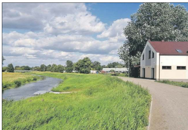
Urzędnicy rozpisali przetarg, który miał wyłonić wykonawcę projektu m.in. bulwarów nad Krzną. Nie zgłosił się żaden oferent
