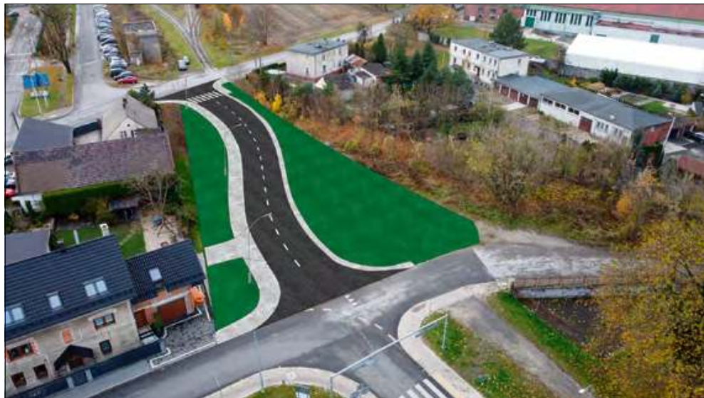
Powstanie łącznik drogowy pomiędzy zjazdem z Mostu Północnego a ulicą Opolską.
