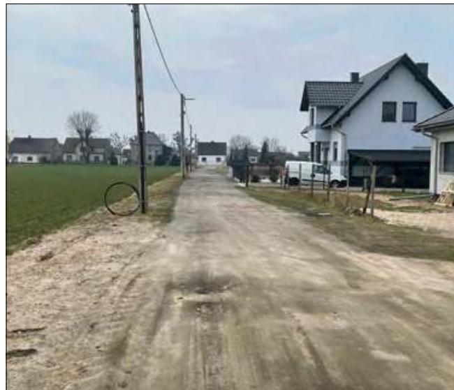
Odcinek ulicy Mickiewicza w Stebłowie zostanie przebudowany.
