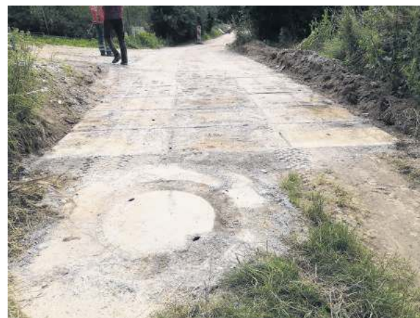
Wykonawca zadbał także o odpowiednie wyprofilowanie studzienek kanalizacyjnych
