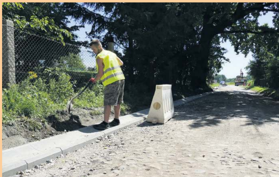
Na 3/4 długości drogi pracownicy firmy budowlanej z Przeworna zamontowali betonowe korytka, odprowadzające wodę
