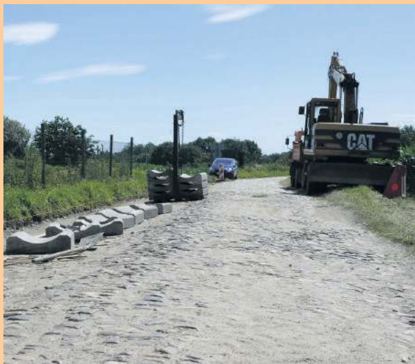
Remont drogi obejmuje 329 metrów
