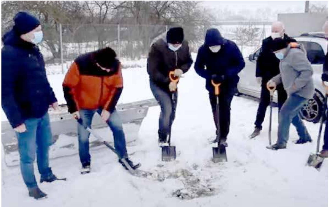
Symboliczny początek budowy oczyszczalni ścieków z kanalizacją
