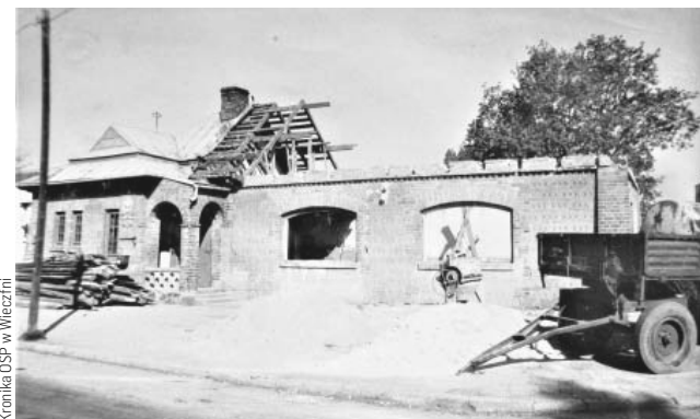
Rozbudowa remizy w Wieczfni, w latach 1988-1989.
