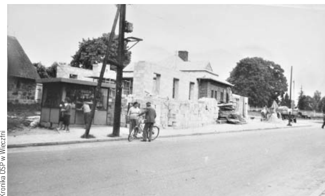
Rozbudowa remizy w Wieczfni, w latach 1988-1989.
