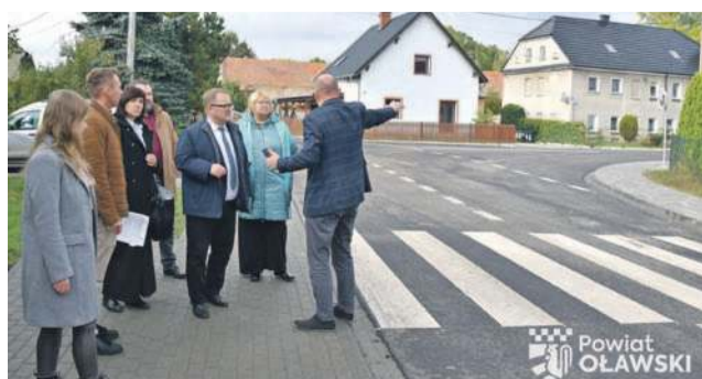
Droga w Wyszkowicach
