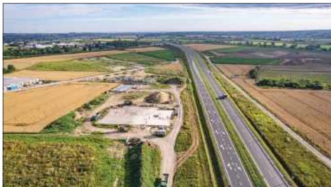
■ Tereny inwestycyjne Raciborza, gdzie zaplanowano budowę nowej fabryki firmy Mieszko
