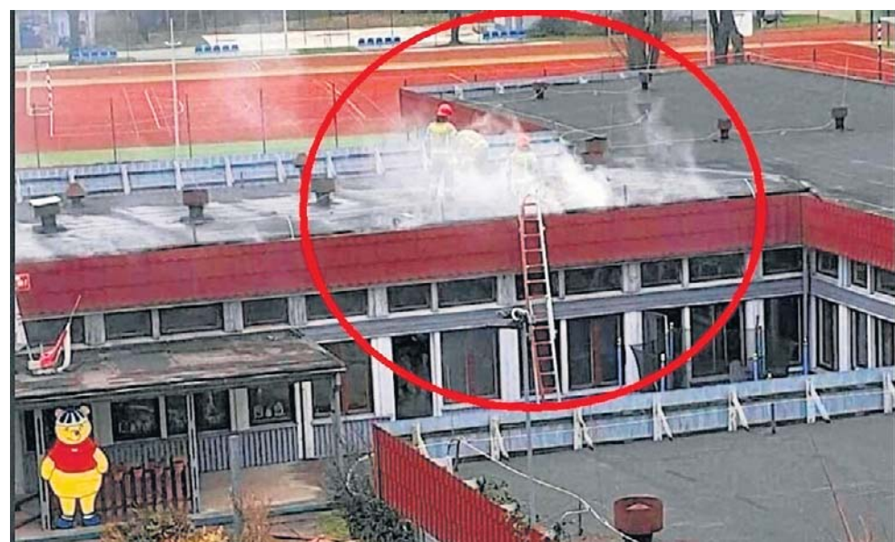
Pomimo szybkiej akcji strażaków zniszczony budynek trzeba było rozebrać.
