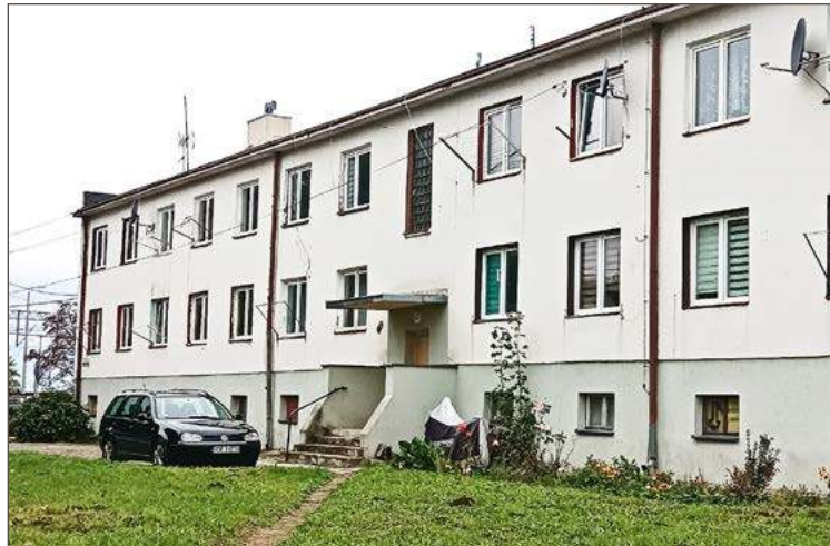
Budynek przy Reymonta jest w fatalnym stanie.
