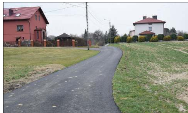
– Dzięki remontom ze szkód kopalnianych, w Gogołowej mamy najlepszy stan dróg gminnych – przyznaje zastępca wójta gminy Mszana Błażej Tatarczyk. Na zdjęciu jeden z zakończonych remontów drogowych na terenie Gogołowej.
