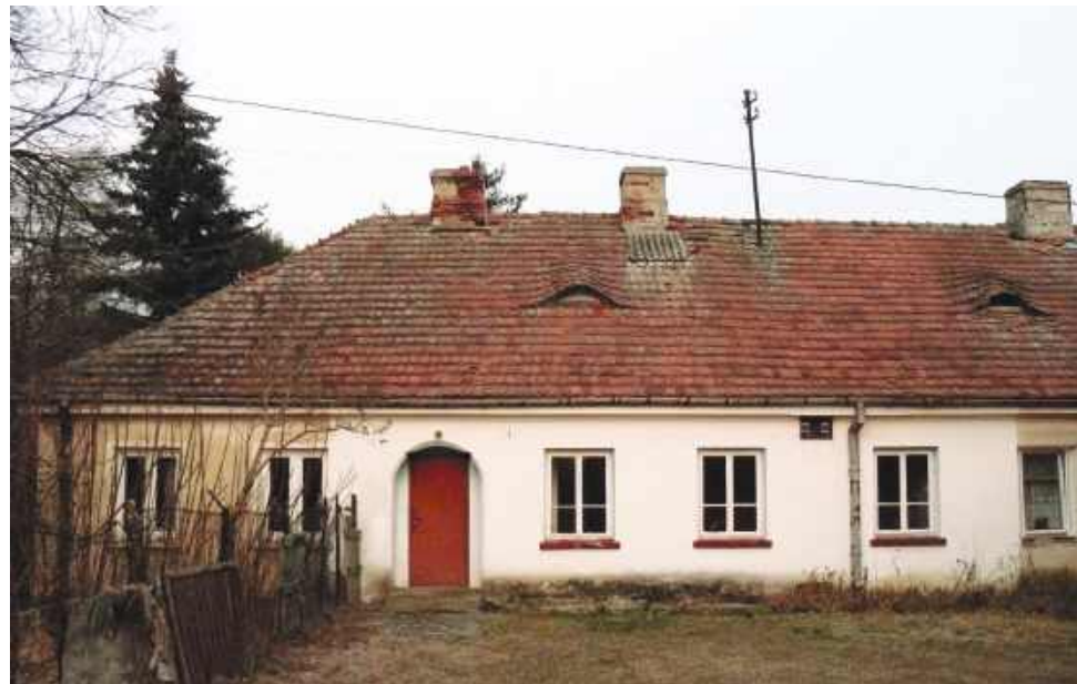
Zabytkowa oficyna przy ruinach pałacu
