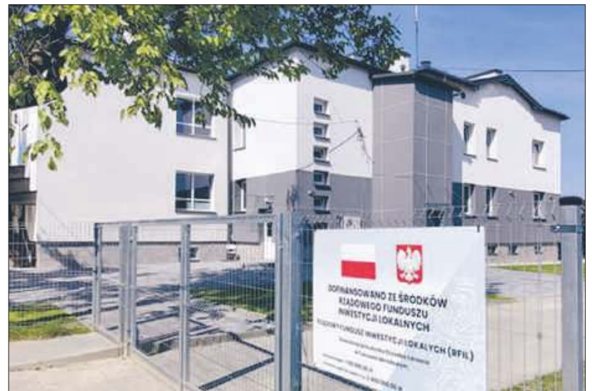
Odnowiony, rozbudowany i bardzo dobrze wyposażony w nowoczesny sprzęt Ośrodek Zdrowia w Tuszowie Narodowym daje możliwość tworzenia kolejnych gabinetów i zwiększenia liczby pracujących w nim lekarzy.
