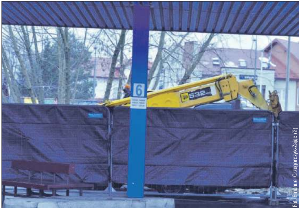
Rozpoczął się remont dworca.
