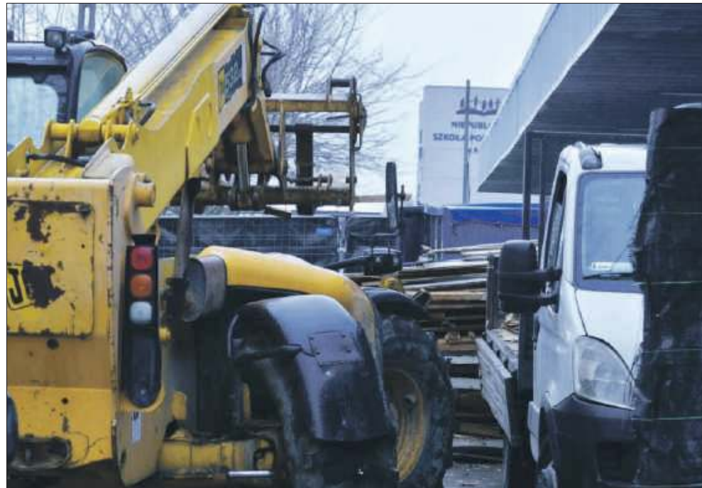
Na miejscu pracowała koparka i ekipa zajmująca się rozbiórką budynków.
