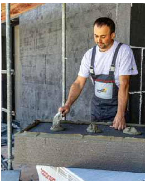
📌 Metoda lekka mokra, nazywana też BSO lub ETICS, polega na zamocowaniu izolacji bezpośrednio do ściany za pomocą kleju. AUSTROTHERM
