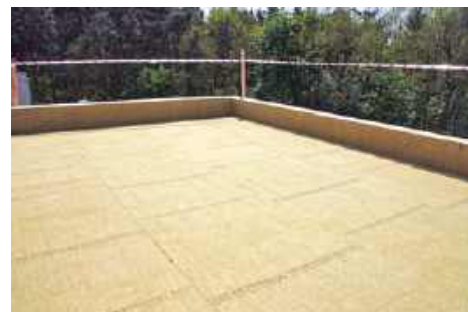
📌 Dach płaski ocieplony od zewnątrz wełną mineralną. ROCKWOOL
