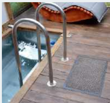
☛ W podestcie osadzono stalowy zbiornik do kąpiel. Ściany wykończono siatką, jak w altanie.
