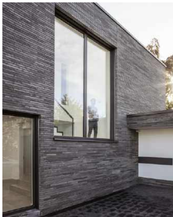
❶ Ciężkie, masywne ściany i stropy mają bardzo dużą zdolność do pochłaniania ciepła. Koniecznie trzeba to uwzględnić dobierając moc klimatyzacji. REHAU
