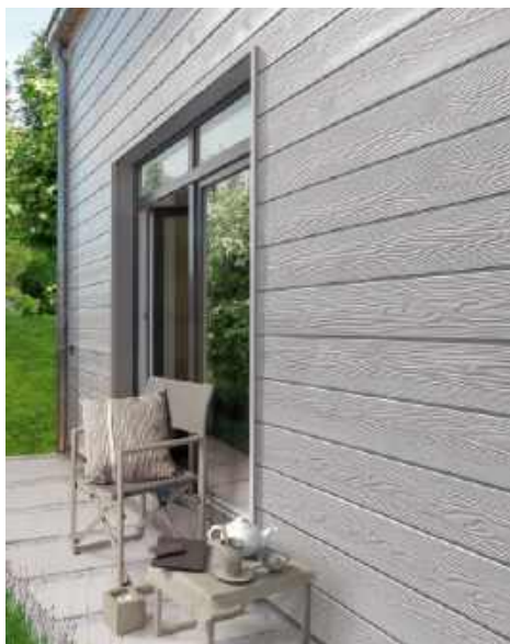
📌 Deski elewacyjne z włókno-cementu mocuje się na zakład lub wpust. Drobne zanieczyszczenia można łatwo spłukać wodą z łagodnym detergentem. CEDRAL
