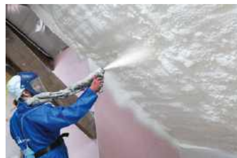
📌 Pianka PUR samoistnie pęcznieje po aplikacji, dlatego bardzo dokładnie wypełnia ocieplaną przestrzeń. ULTRAPUR
