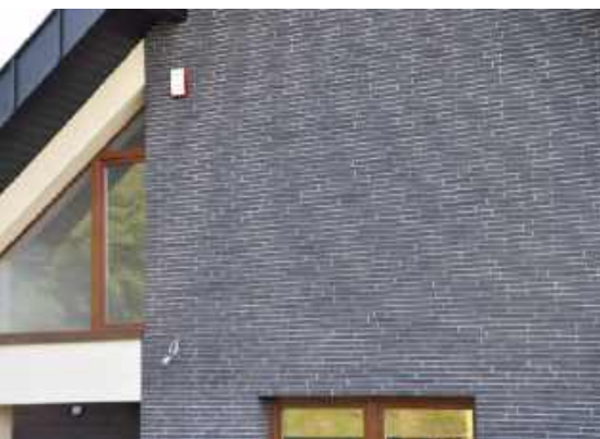
📌 Mineralne płytki bardzo dobrze naśladują klinkier, ponieważ przebarwienia, niuans kolorystyczne oraz struktura powierzchni każdej płytki wykonywane są ręcznie. ELASTYCZNY KLINKIER/ELASTOLITH
