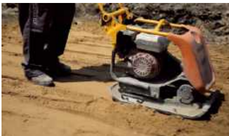
2 Ułożoną warstwę podbudowy należy ustabilizować zagęszczarką. BRUK-BET
