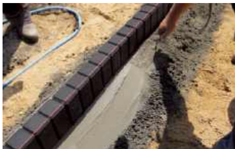
1 Obrzeża układa się po wykonaniu wykopu pod nawierzchnię. BRUK-BET
