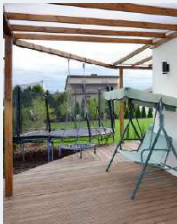
R yflowane deski tarasowe (z sosny) przytwierdzono do legarów wkrętami do drewna.
