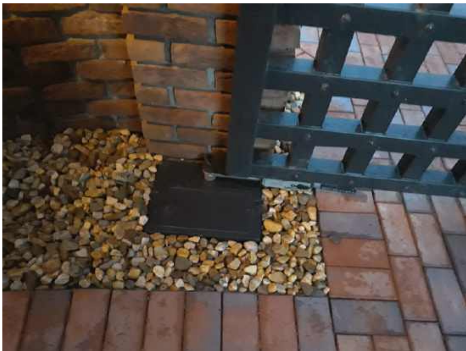
🔧 Część producentów oferuje napędy (do bram przesuwnych) przeznaczone do montażu pod powierzchnią ziemi w hermetycznej skrzynce. BENINCA
