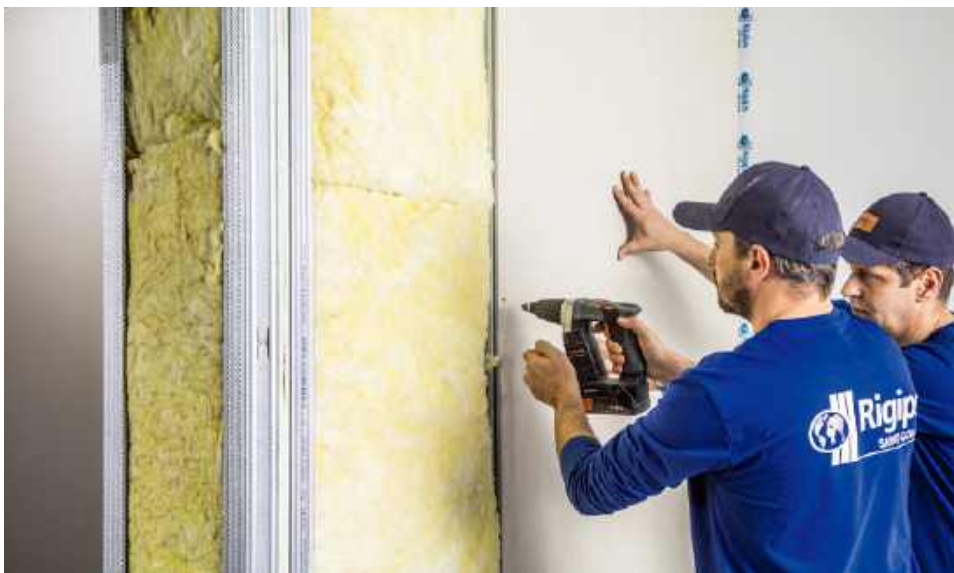
❗ Przy wykonywaniu ścianki akustycznej między rusz wkłada się płyty z wełny mineralnej i przykrywa płytami g-k, mocowanymi do stelaża przy użyciu wkrętów. SAINT GOBAIN (RIGIPS)
