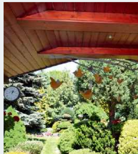
📌 Zadaszenie jest pełne, grube, drewniane (plus na zewnątrz blachodachówka).
