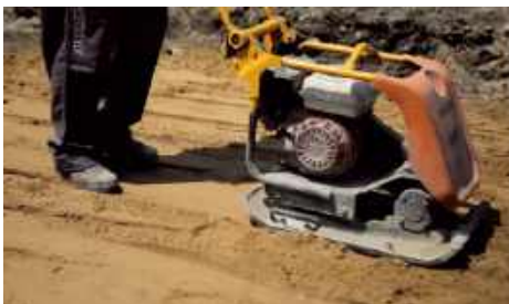
2 Ułożoną warstwę podbudowy należy ustabilizować zagęszczarką. BRUK-BET
