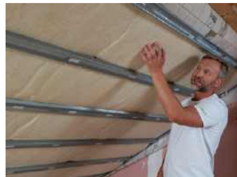
📌 Dachy spadziste izoluje się z reguły od spodu, wykorzystując wełnę mineralną. Materiał ten charakteryzuje się dużą sprężystością włókien, więc można go dobrze wpasować pomiędzy krokiewie. ISOVER
