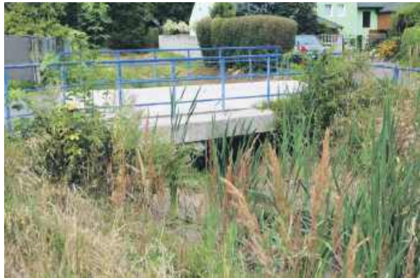
Potok Nieszkowicki w Kazanowie ma zostać udrożniony
