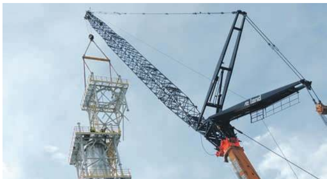
Montaż kolumny destylacyjnej. Jej wysokość to 77 metrów
