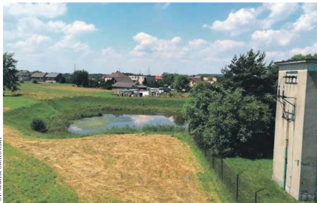
Polder obejmie m.in. teren przepompowni w Gromcu
