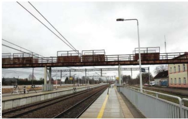
Stara kładka nad torami w Morągu
